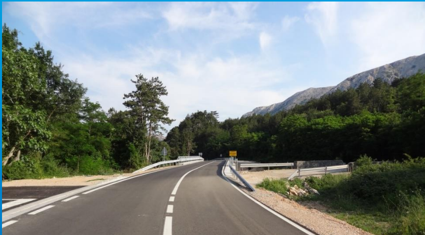
Dc 102, novi most „Bašćanska draga II“ i desno stari most
