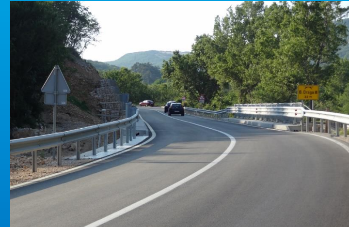
Dc 102, novi most „Bašćanska draga III“, smjer Punat
