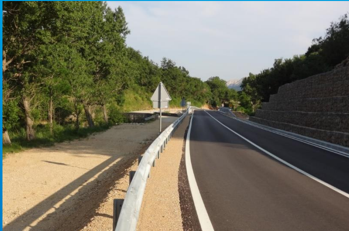
Dc 102, novi most „Bašćanska draga II“ i desno stari most
